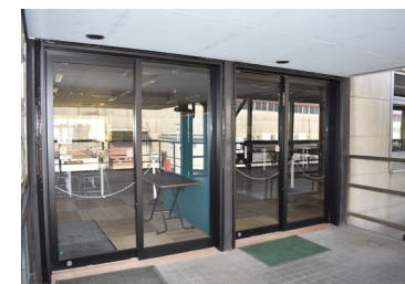
出入口を自動ドア化
