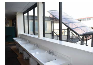
手洗い場を設置(温水機能追加)
