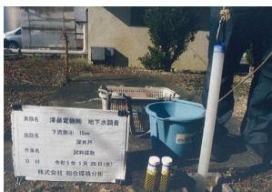
下流側汚染状況調査の様子
