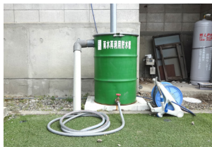
雨水をタンクに蓄え再利用
