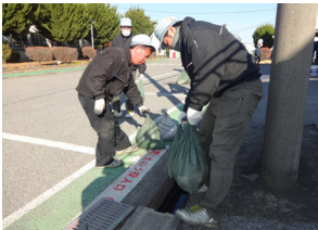
土のうでせき止め処置
