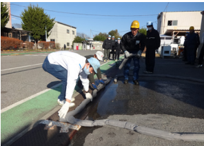
オイルフェンスで油拡散の防止処置
